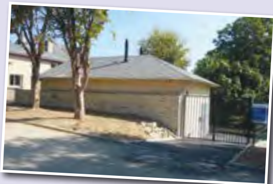
Construction d'une chaufferie à bois déchiqueté avec réseau de chaleur.
