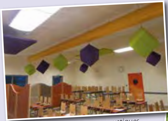
Pose de panneaux acoustiques au restaurant scolaire
