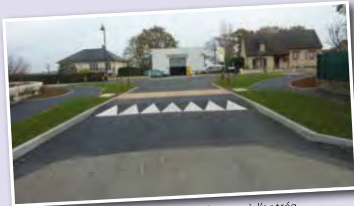
Aménagement d'un plateau à l'entrée du lotissement de l'Etoile, zone 30 km/h priorité à droite.
