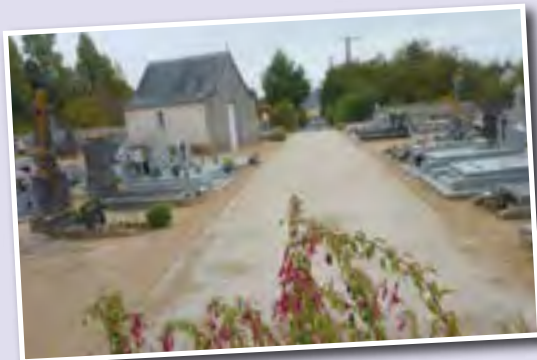
Réfection de l'allée du cimetière.
