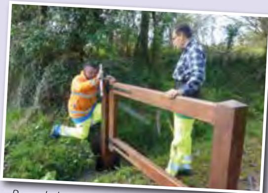
Pose de barrières dans les zones à sécuriser.
