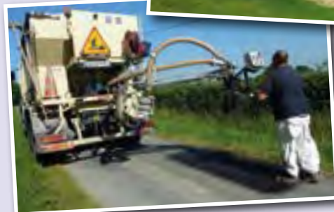
Passage d'un blow-patcher pour l'entretien des voiries
