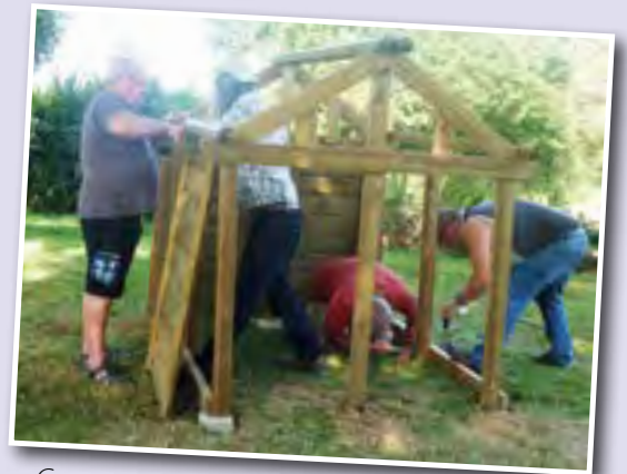
Construction d'une cabane en bois pour l'aire de jeux du lotissement de l'Etoile.
