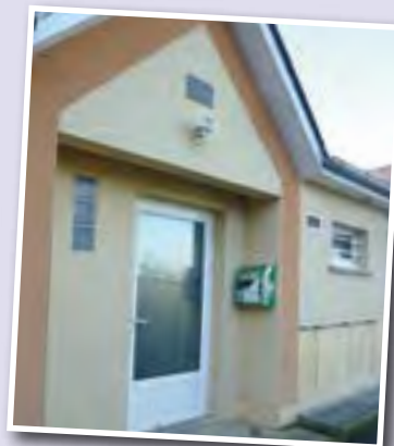
Installation d'un défibrillateur à l'extérieur des vestiaires sportifs.
