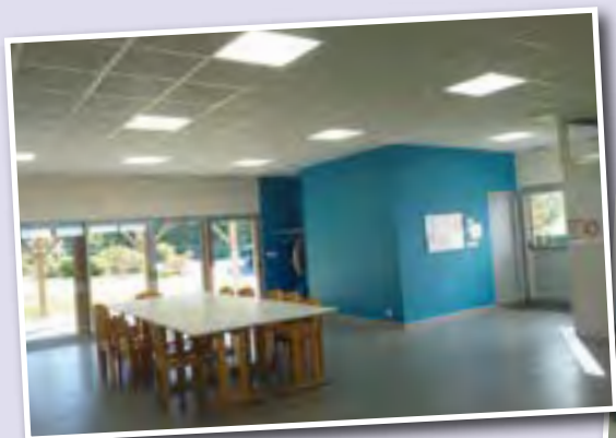
Mille club, installation d'un plafond rayonnant électrique, réfection du carrelage et aménagement d'un bloc sanitaire aux normes.
