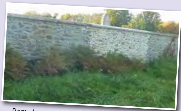
Remplacement du vieux portail du cimetière par un mur.
