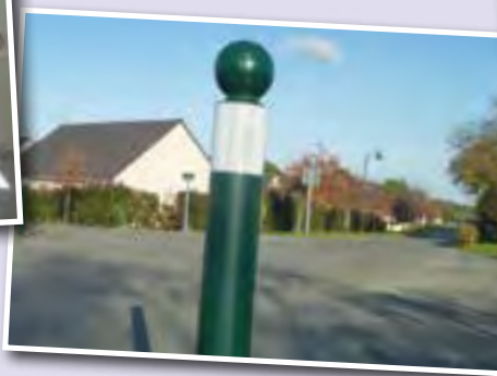
Remplacement des bornes par des potelets à mémoire de forme.
