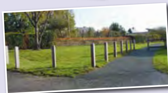
Installation de barrière de sécurité aux abords des espaces verts.
