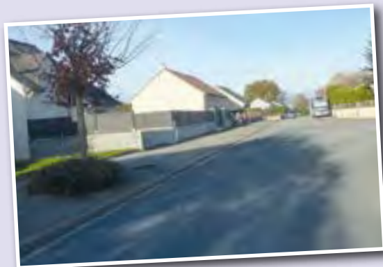
Réalisation d'un revêtement bicouche au lotissement de l'Etoile.
